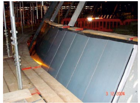
... und anschließend Kompositpaneele aus Aluminium und Zink montiert.
