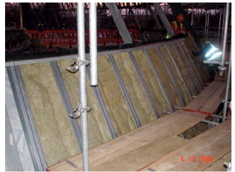
... wird zuerst Wärmedämmung zwischen Klemmprofile eingebracht ...
